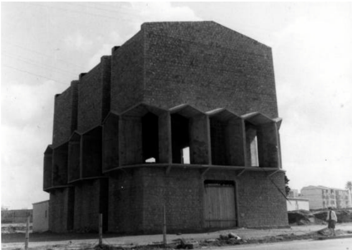
veduta dell'edificio durante il cantiere
