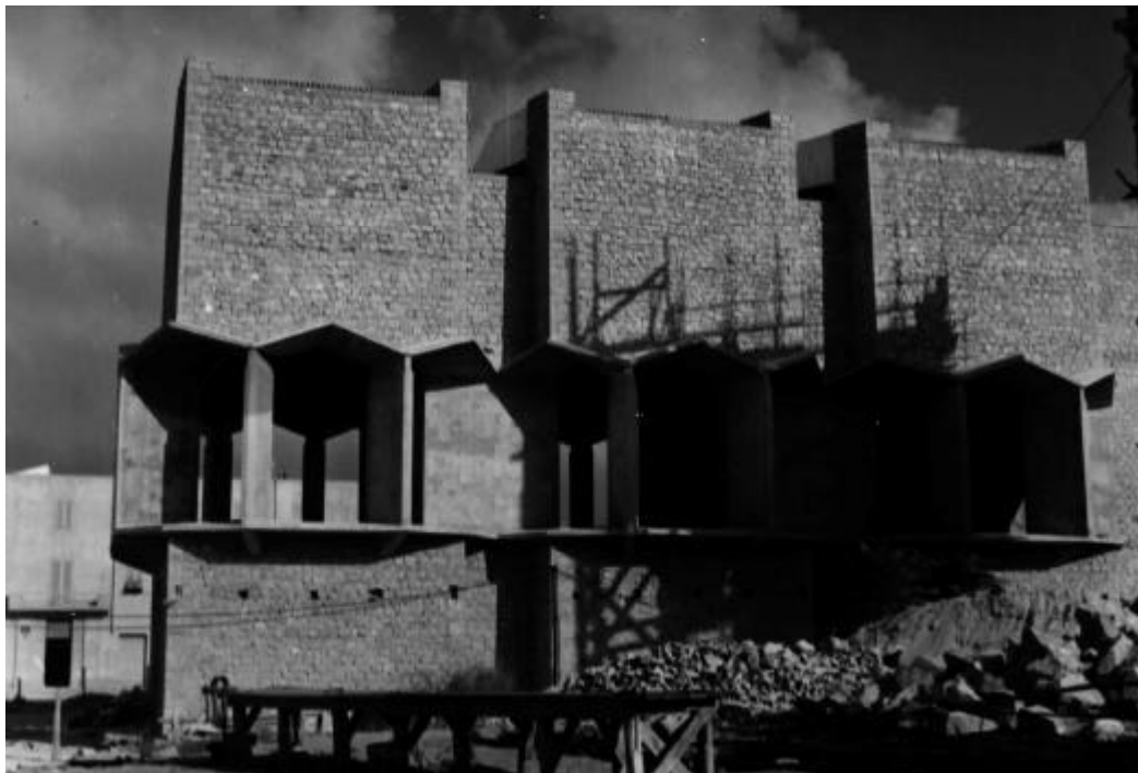
veduta del cantiere
