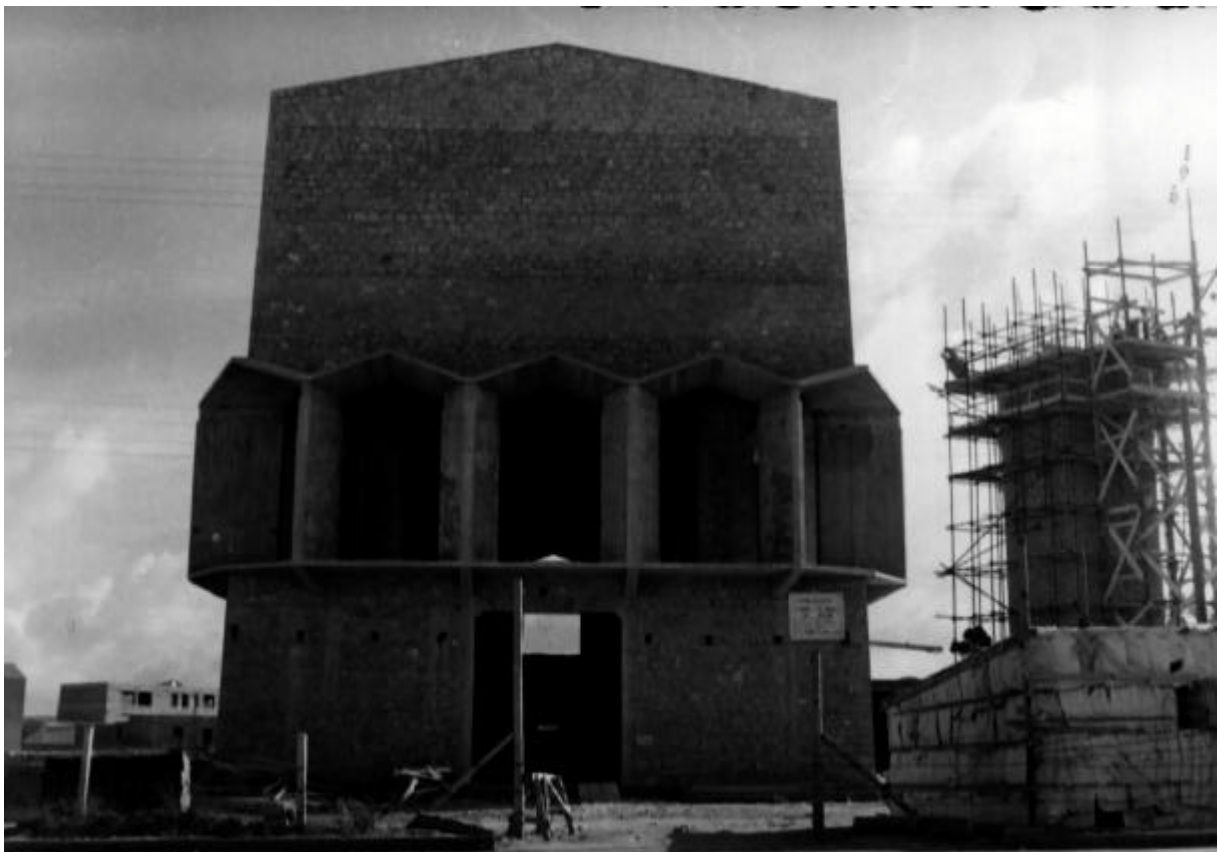
prospetto principale cantiere
