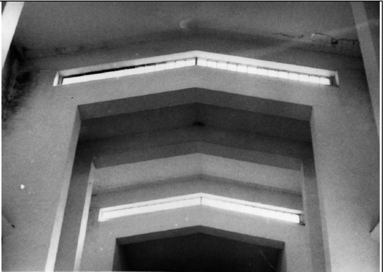
dettaglio copertura interno
